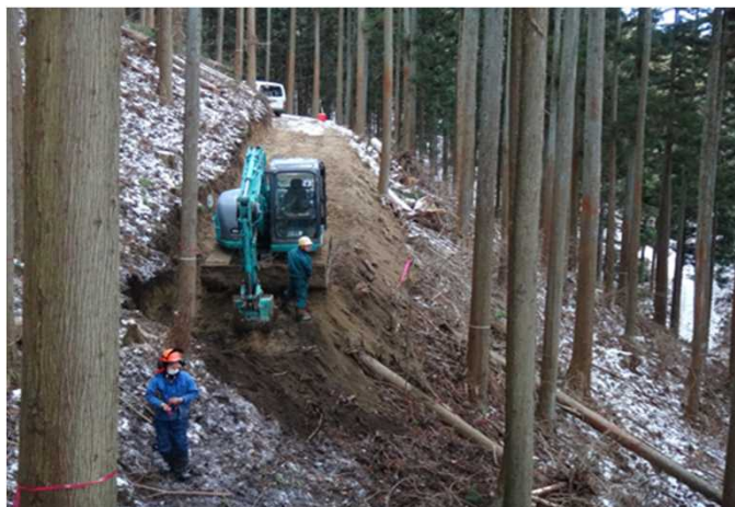
作業道の整備状況
