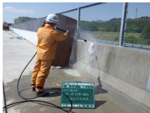
橋梁の洗浄作業
