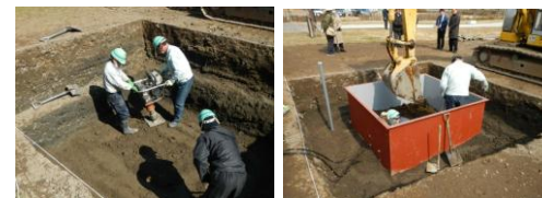
試験施工の様子
