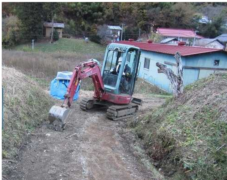
図 2-39 未舗装道路の除染の例（削り取り）
