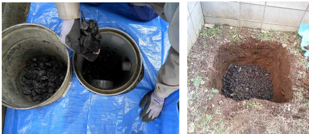
図 2-25 雨水枡の除染の例（堆積物除去と同一敷地内における雨水枡堆積物の天地返し）
