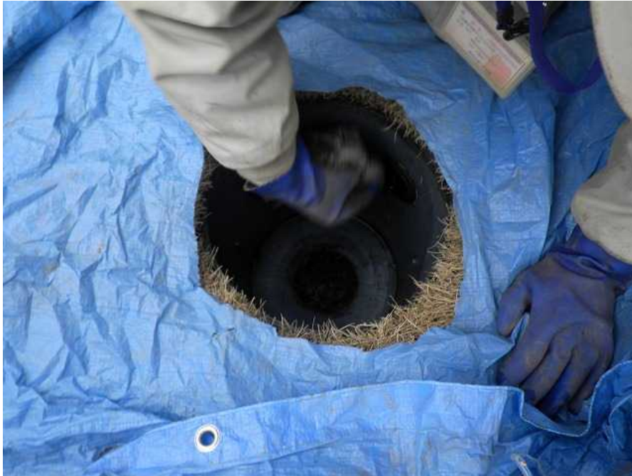
図2-27 雨水枡の除染の例（スポンジ洗浄）
