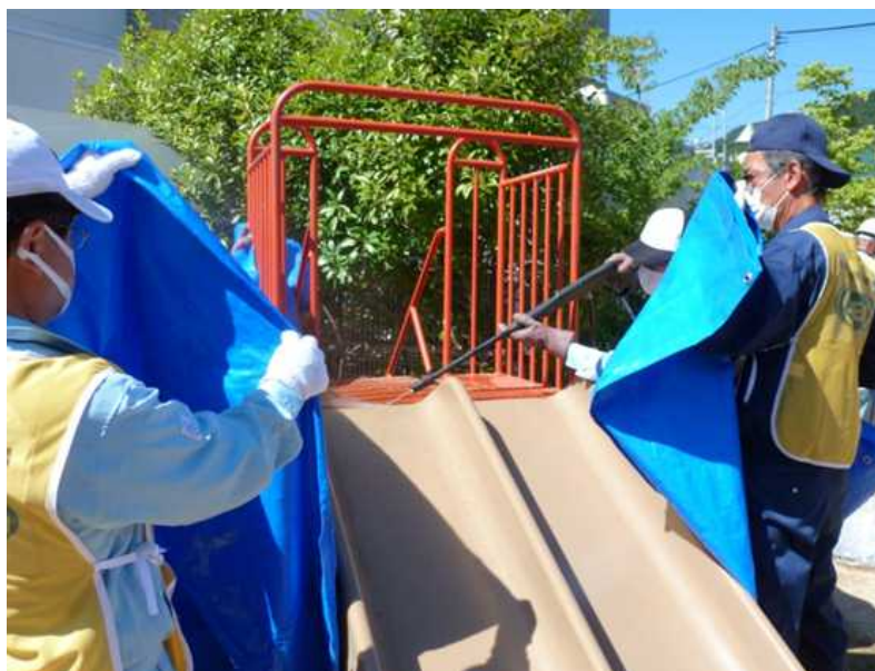
図 2-17 遊具の除染の例（高圧水洗浄）
