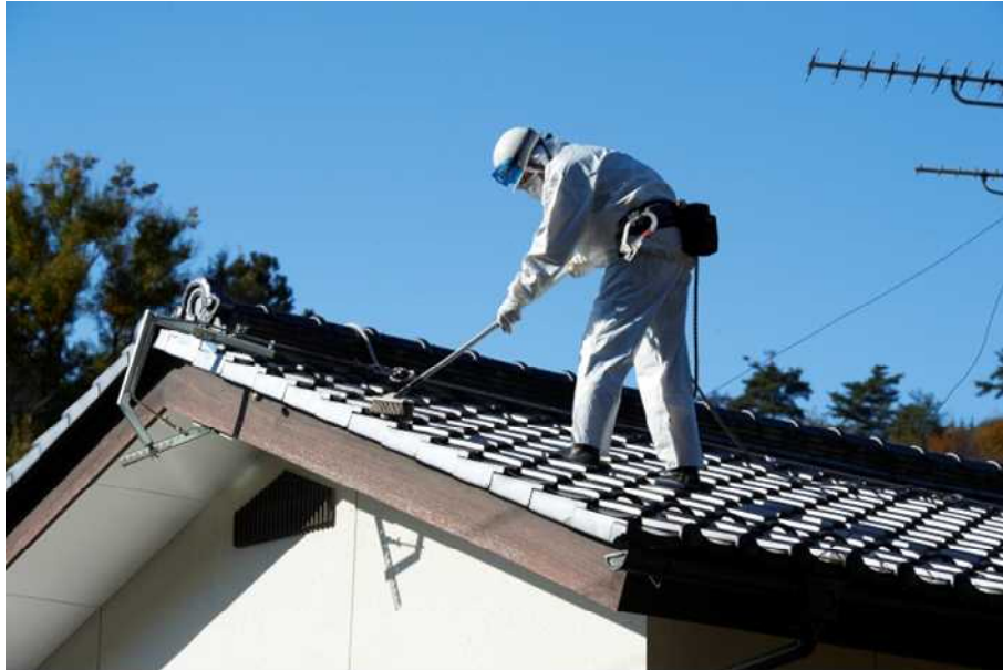
図 2-10 屋根の瓦の除染の例（洗浄）
