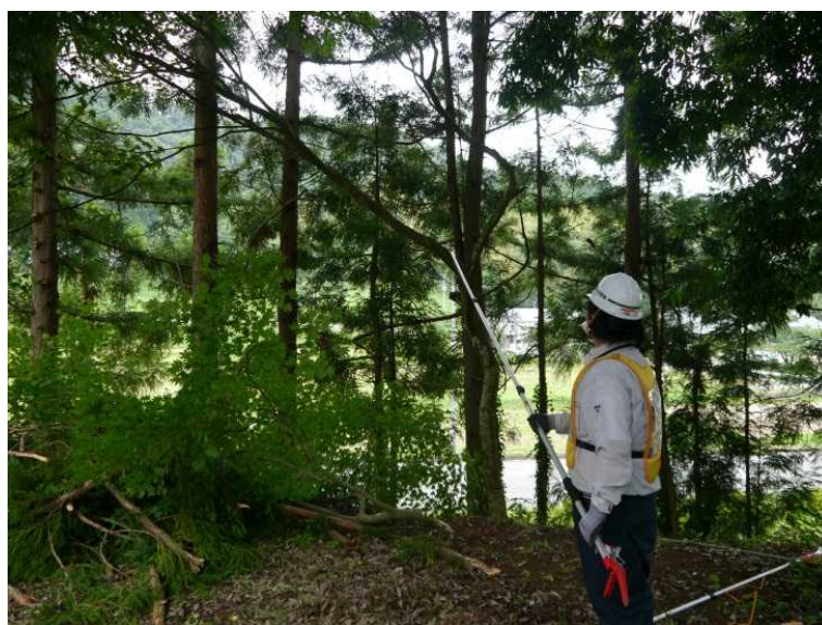
図2-64 森林の除染の例（枝葉等の除去）
