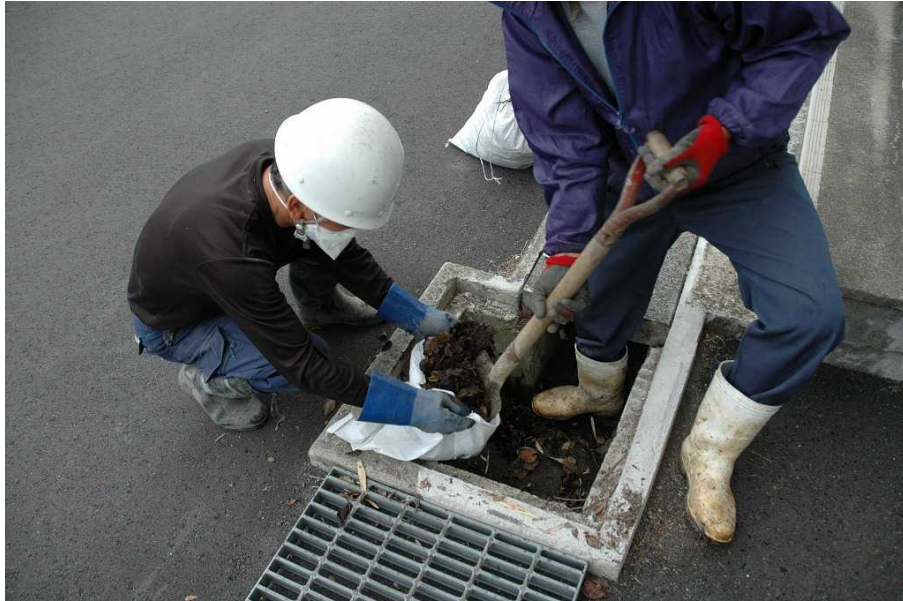
図 2-23 側溝の除染の例（堆積物除去）
