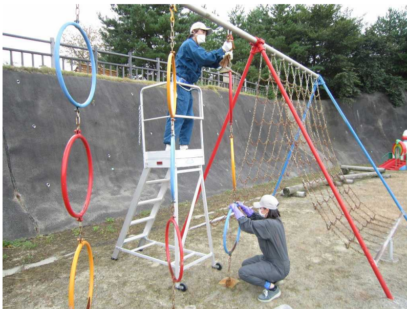
図 2-16 遊具の除染の例（拭き取り）
