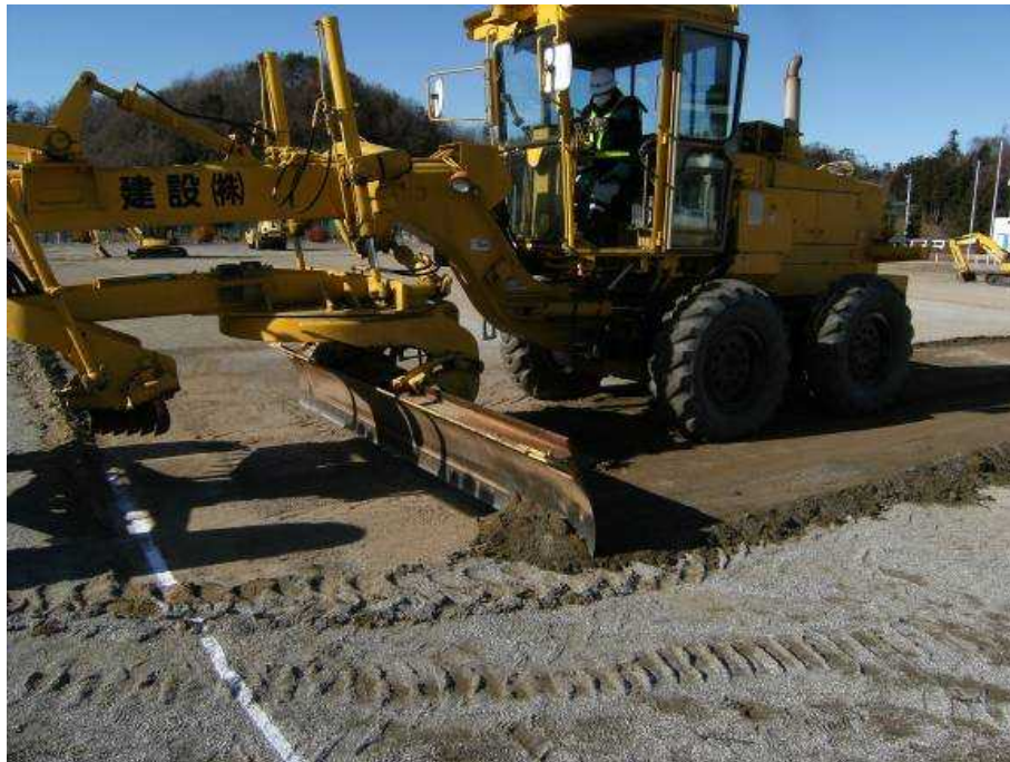
図 2-50 校庭の除染の例（表土の削り取り）
