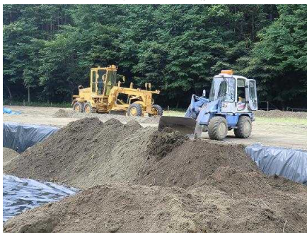
図4-9 現場保管（学校：地下保管）の例（写真提供：白河市）
