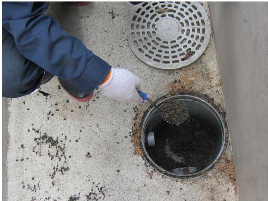
図 2-24 雨水枡の除染の例（堆積物除去）
