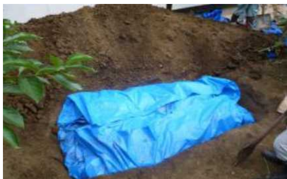
図4-6 現場保管（地下保管）例
