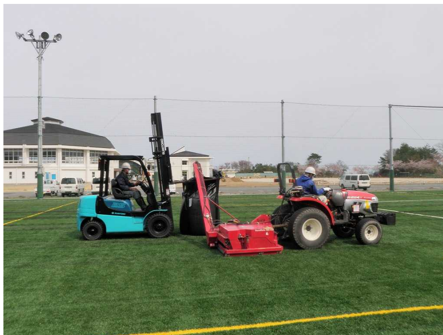
図 2-51 人工芝の充填材の除去の例
