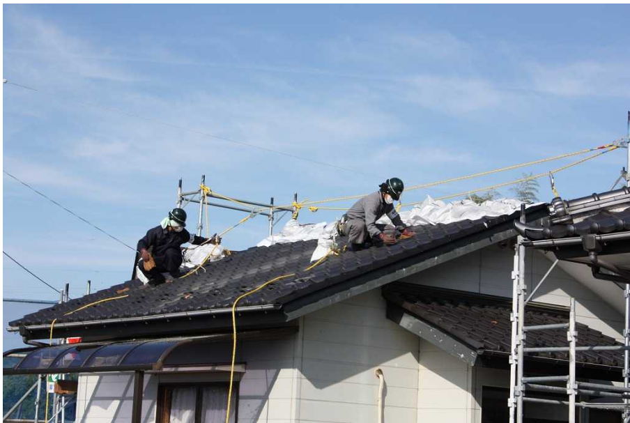
図2-9 屋根の瓦の除染の例（拭き取り）
