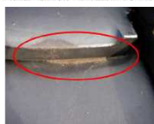
いぶし瓦 瓦の重ね合わせ箇所
