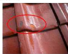
釉薬瓦 釉薬の剥がれた箇所
