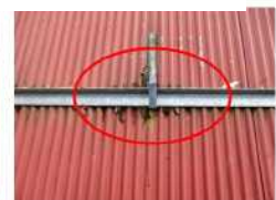
トタン 雪止め箇所
