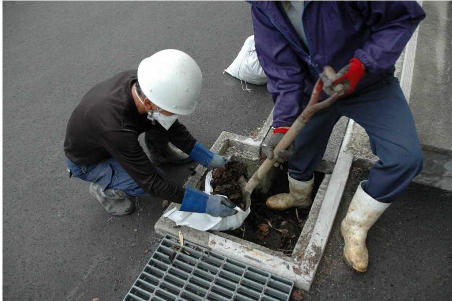
図 2-23 側溝の除染の例（堆積物の除去）
