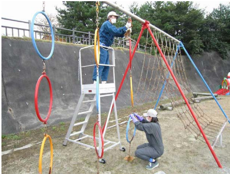
図 2-16 遊具の除染の例（拭き取り）
