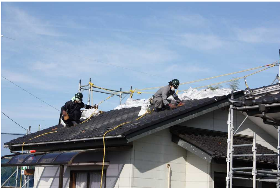
図2-9 屋根の瓦の除染の例（拭き取り）
