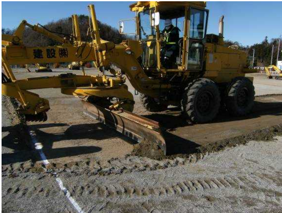
図 2-50 校庭の除染の例（表土の削り取り）
