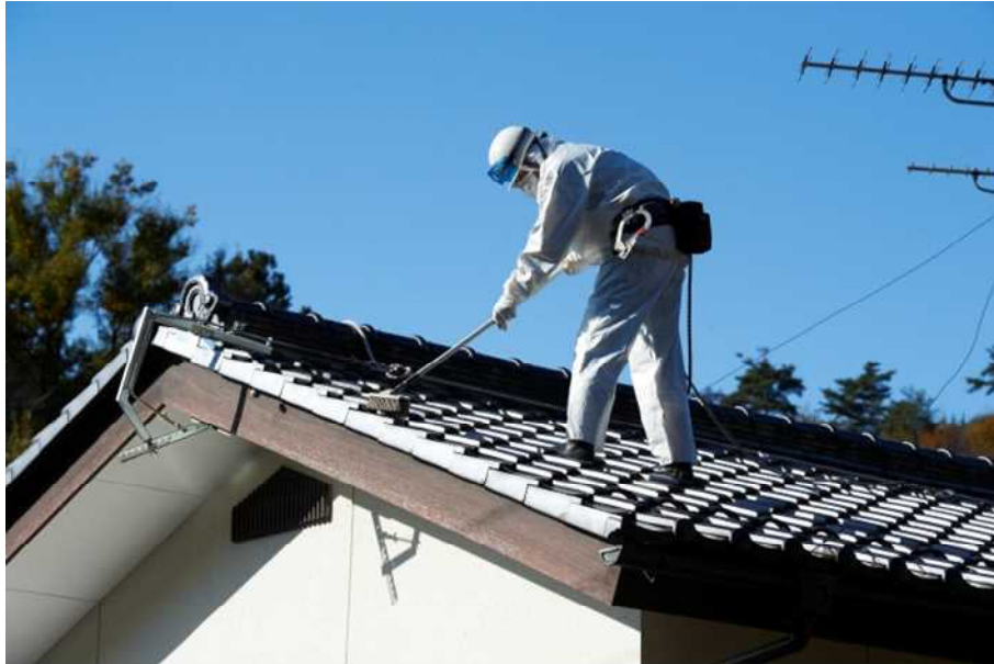
図 2-10 屋根の瓦の除染の例（洗浄）
