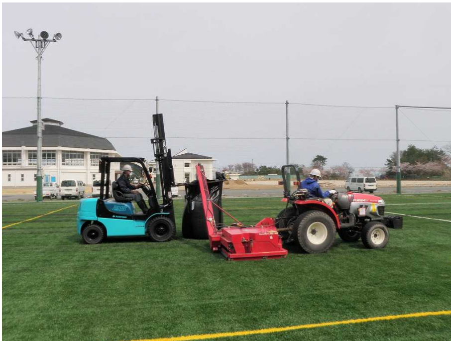
図 2-51 人工芝の充填材の除去の例
