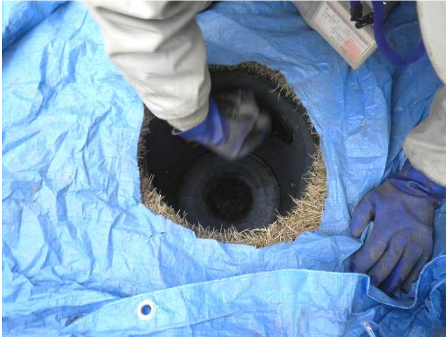
図 2-27 雨水枡の除染の例（スポンジ洗浄）
