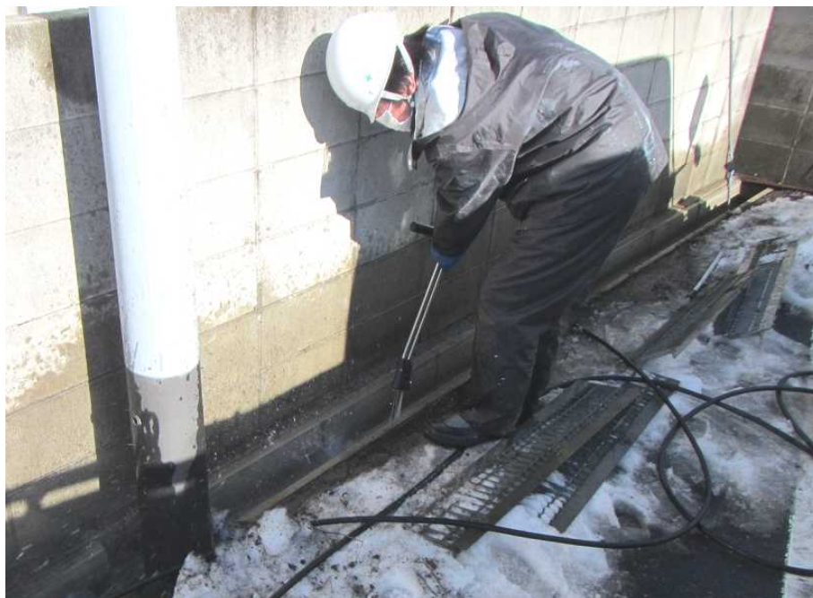
図 2-26 側溝の除染の例(高圧水洗浄)
