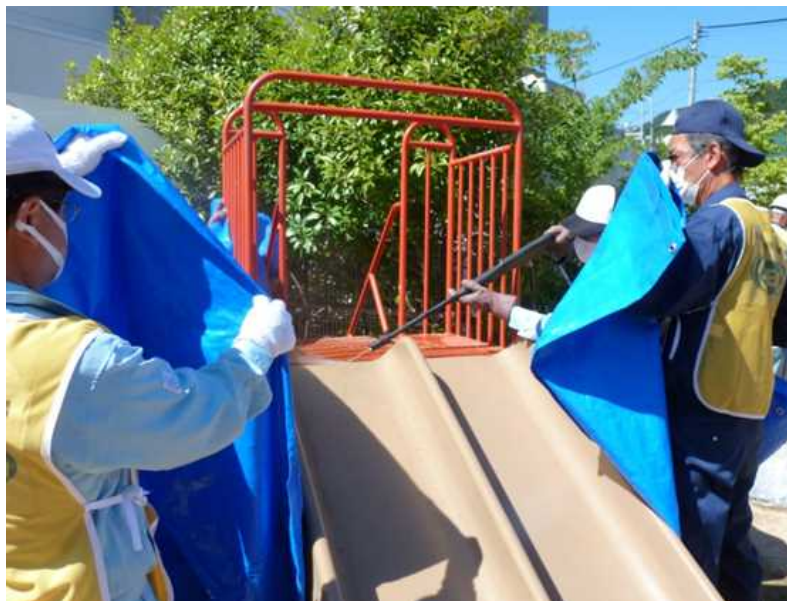
図 2-17 遊具の除染の例（高圧水洗浄）
