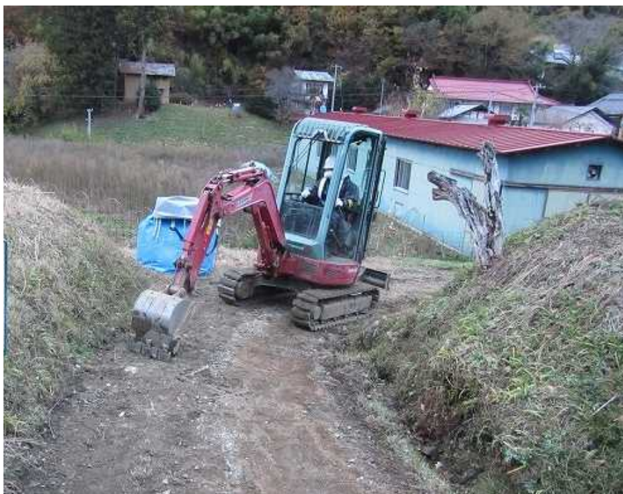
図 2-39 未舗装道路の除染の例（削り取り）
