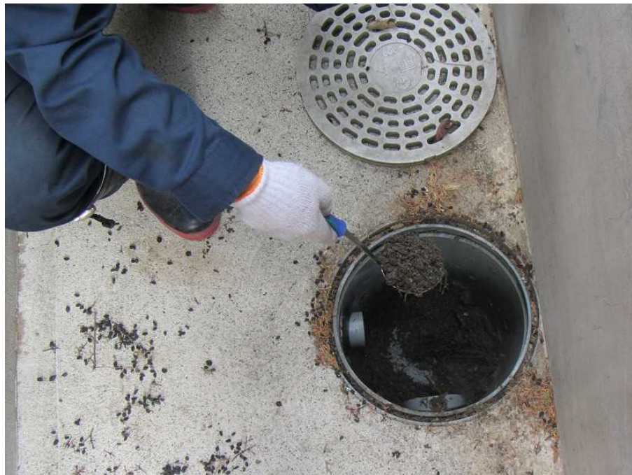
図 2-24 雨水枡の除染の例（堆積物の除去）
