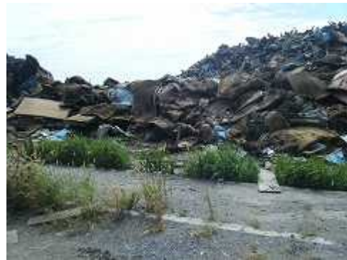
長浜地区仮置場 火災後状況(畳)-2
