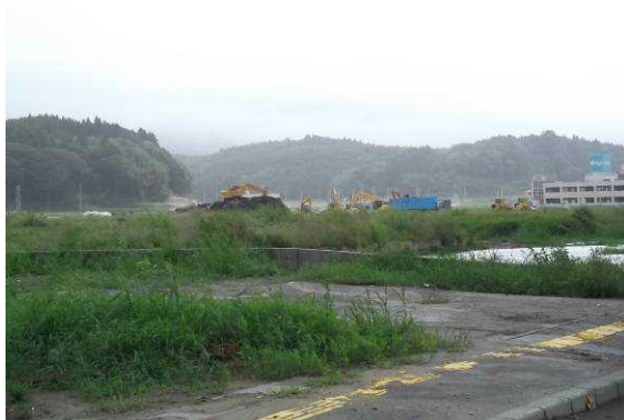
森の前仮置場 重機による粗選別の状況
