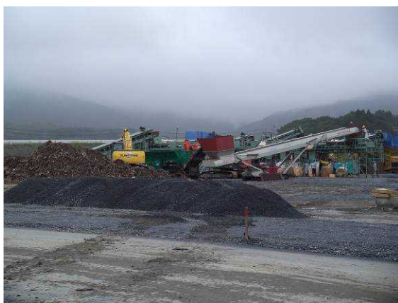
木材系混合物の破碎・選別ライン
