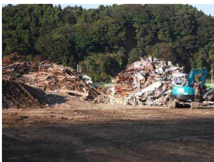
木くず類分別作業状況
