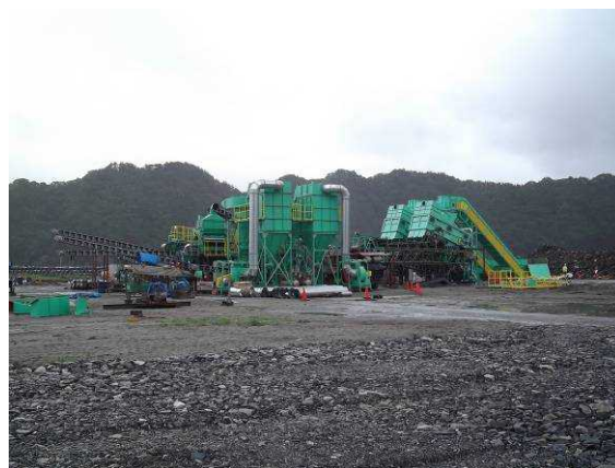
片岸地区仮置場（二次仮置場） 混合物処理ライン（工事中）
