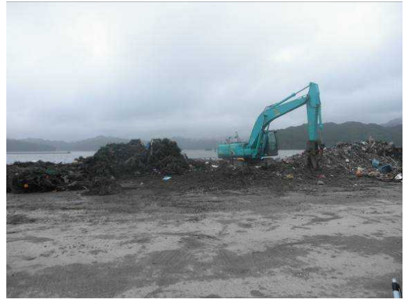
重機による漁具の裁断・選別
