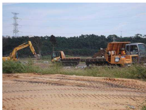
災害廃棄物分別作業状況
