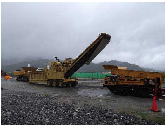
片岸地区仮置場（二次仮置場） 木くず処理ライン（工事中）
