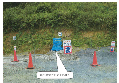
指定廃棄物の保管状況
