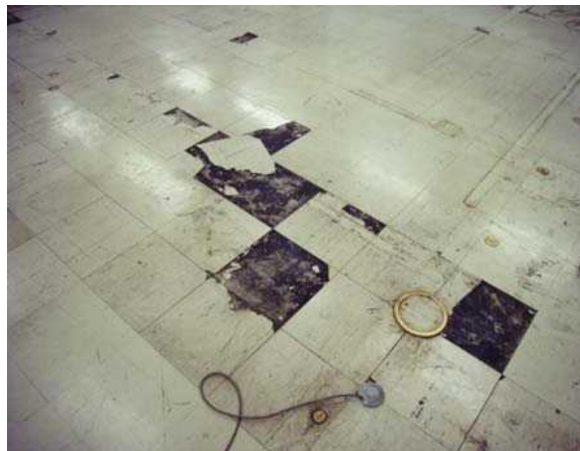
石綿含有ビニル床シート
