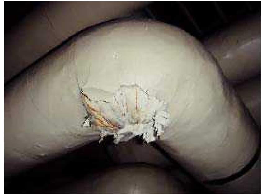
保温材(配管エルボ)
