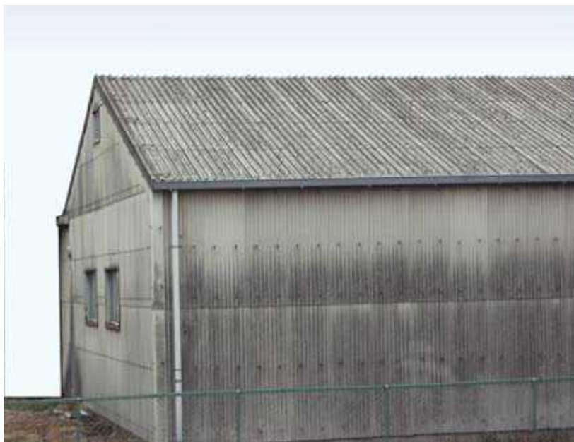
石綿含有スレート波板
