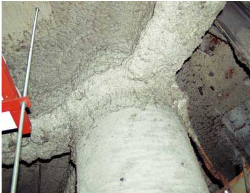
吹付け石綿(鉄骨耐火被覆材)
