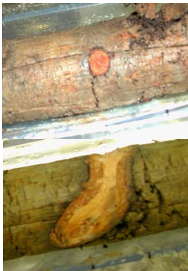
コアサンプラー挿入で切断された生根
