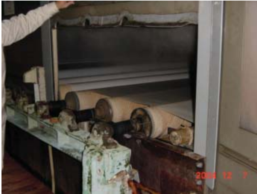
写真 2 扉開閉の様子
