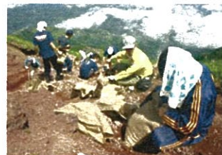
ボランティアとの連携作業(利尻山登山道の補修)
