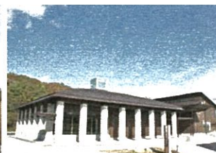
利用施設の整備事例(那須ビジターセンター)
