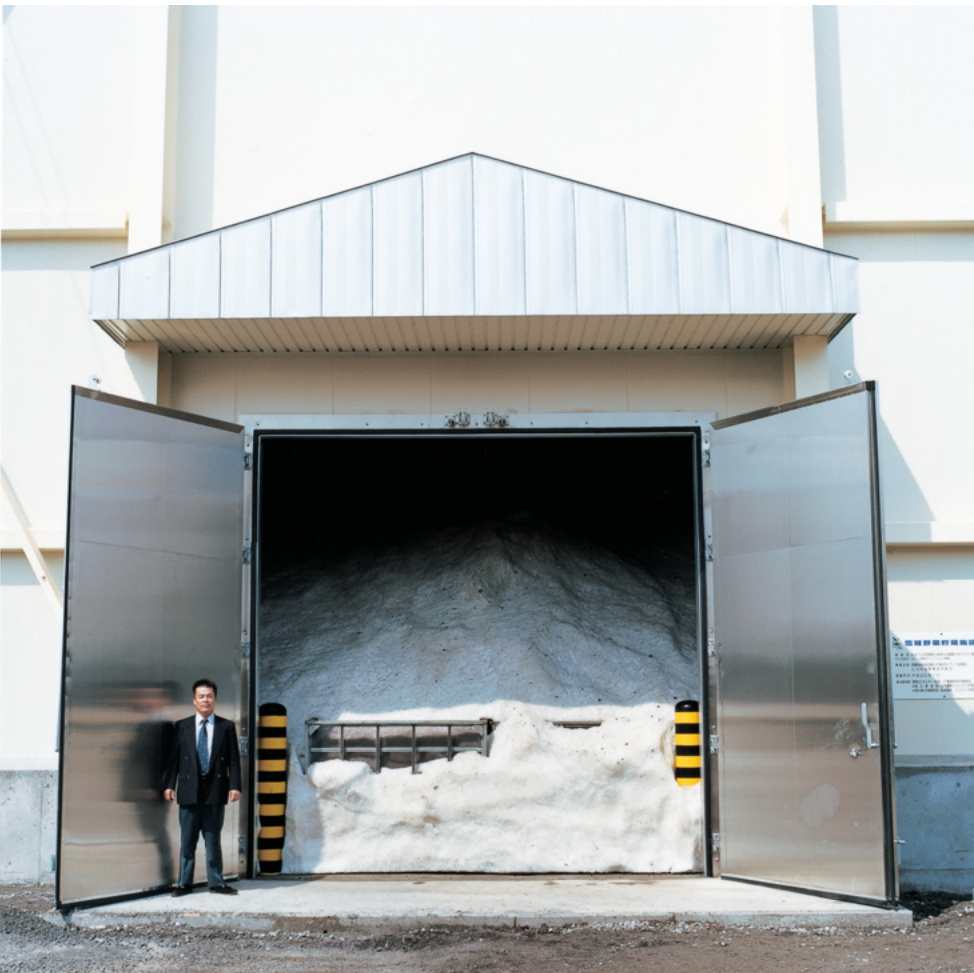
雪蔵 JAとうや湖に建設された雪蔵野菜貯蔵施設。2年間試験を繰り返し、平成19年度より本格的に移動しました。雪深い土地ならではの天然のエネルギー資源を活用した施設です。右は、雪蔵に貯蔵されたじゃがいも。
