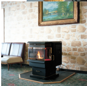
ペレットストーブ 洞爺湖温泉の宿泊施設では、この地域で製造されるペレット（木製チップ）を利用したストーブを設置し、電力の削減に貢献しています。
