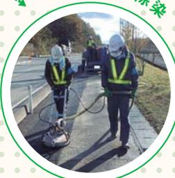
道路の場合は、まずたまったごみを取り除いた後で、高圧水を使って洗浄していく。汚水とともに取り除かれた放射性物質を回収し、処理するなどの方法で除染を進めた
