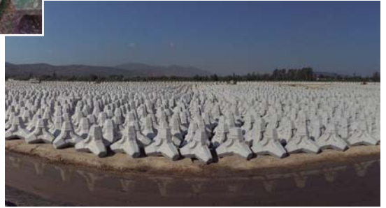
(左)一般的なコンクリートと比べると、藻類の成長度合いの差は明らか。[左端：普通コンクリート、右3つ：異なる濃度のアルギニンを混和したコンクリート] (下)ベトナム・ニソン製油所での展開が始まった日建工学の消波ブロック「ラクナ・IV」
