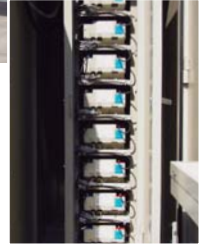
(左)滝沢市庁舎屋上に設置された太陽光発電／(右)蓄電容量17kWhの蓄電池
