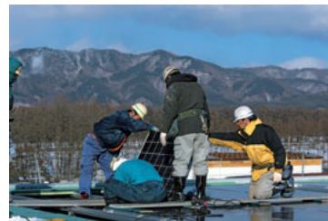
商工会議所の屋根にも、現在パネルを取り付け作業中。
