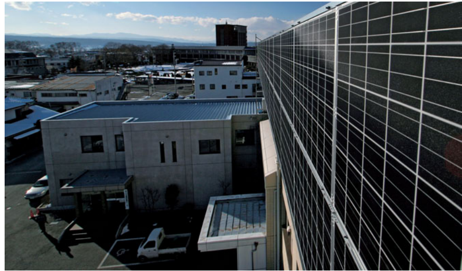
佐久商工会議所の側面に設置された、太陽光発電パネル。
