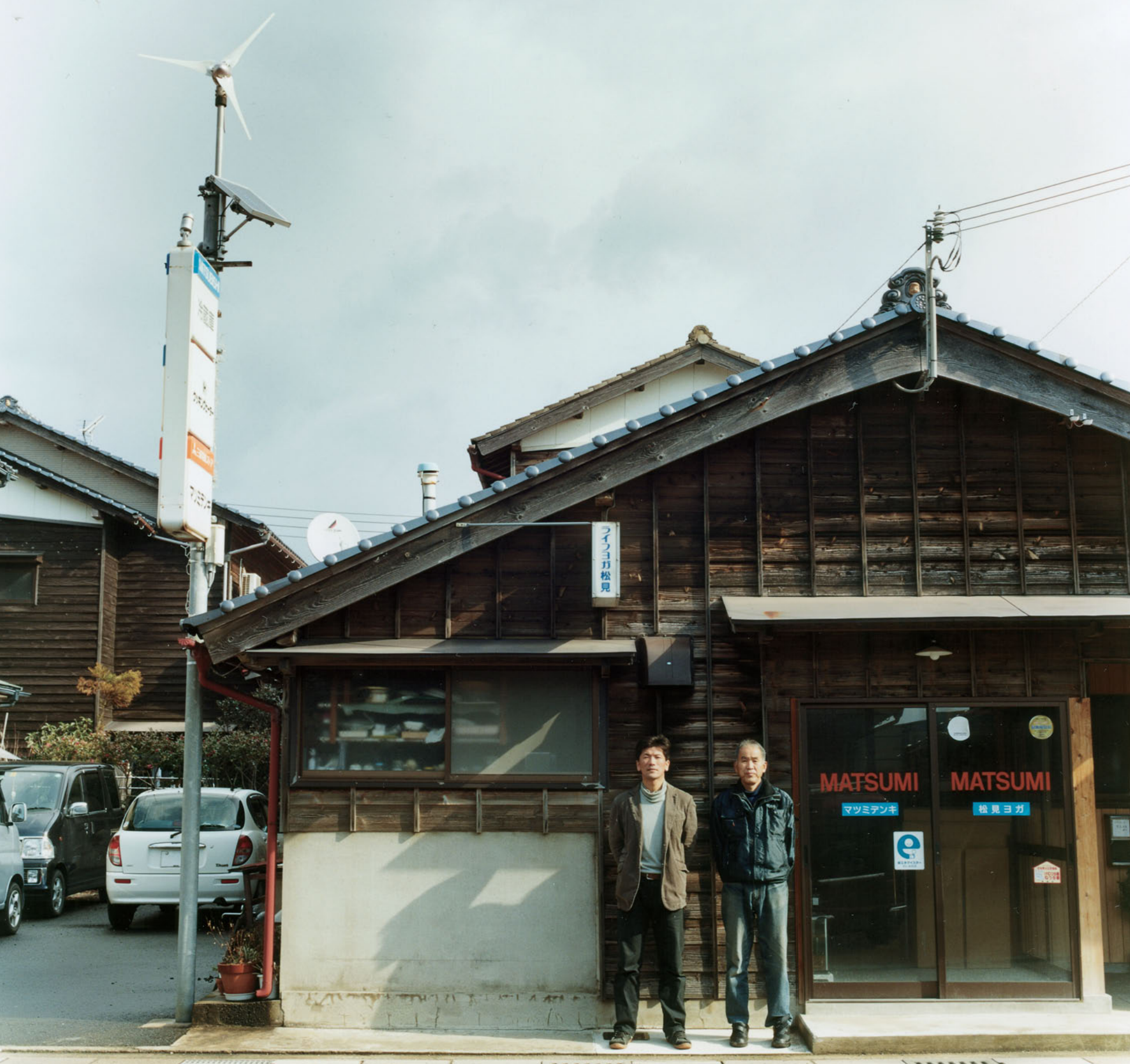
電気工事士の松見弘睦さんの店舗に設置された風力発電機。太陽光発電と併用しており、入口の外灯の電力をまかなっている（京都府京丹後市）。
