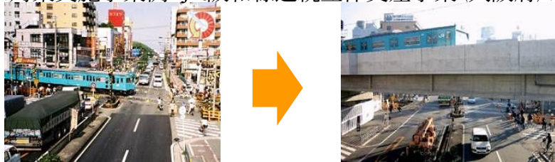
整備前後でのJR阪和線 (長居南1踏切) の状況
