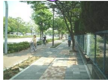
歩道、自転車道の整備
