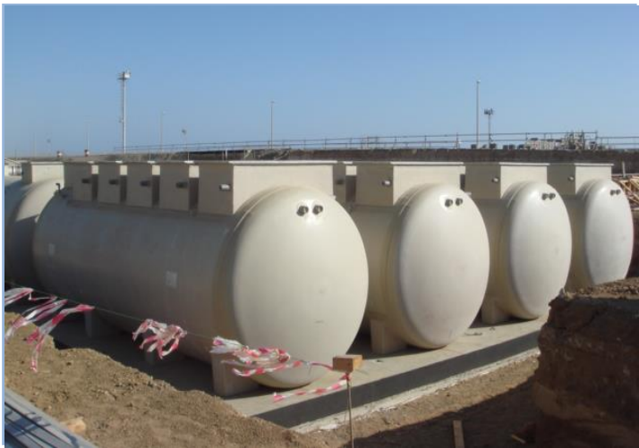
従業員宿舎 (サウジアラビア: 2,120人槽)
