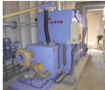
木質ペレット焚き温水ボイラー 二光エンジニアリング社製 RE - 35N 407KW
