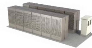
自立型電源 (蓄電池設備含む)
