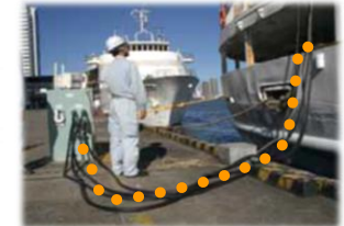
電力供給設備
