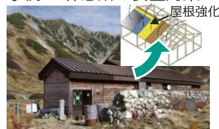
耐震化・屋根強化改修 （中部山岳立山）
