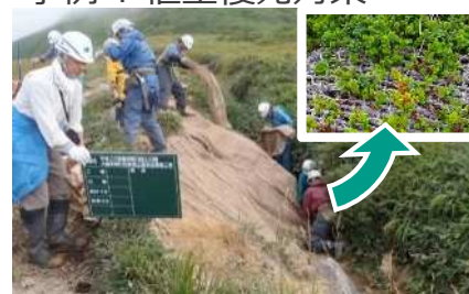
緑化による法面崩壊防止 （磐梯朝日 朝日連峰）
