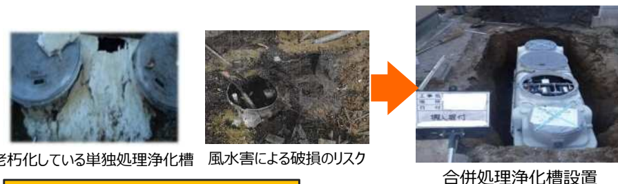
合併処理浄化槽設置
