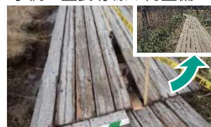
老朽化木道の改修 （日光 戦場ヶ原）
