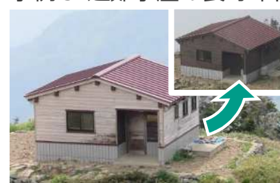
避難小屋の外壁塗装による長 寿命化対策（白山）
