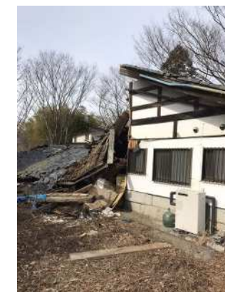
②損壊した家屋等の解体、がれきの収集・運搬及び処分
