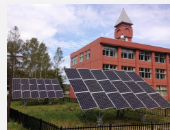
避難所に設置した太陽光発電
