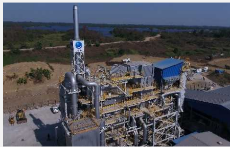
日本の技術の国際展開の一環として、JCMを通じて途上国に導入された 廃棄物発電施設
