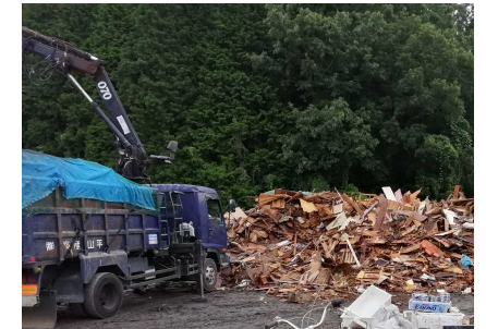
②損壊した家屋等の解体、がれきの収集・運搬及び処分
