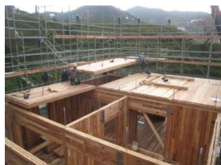
CLTを用いた施工例
