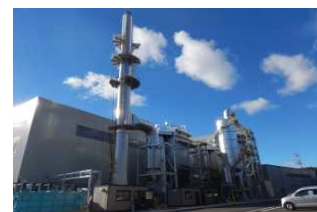
檜葉町の仮設焼却施設
