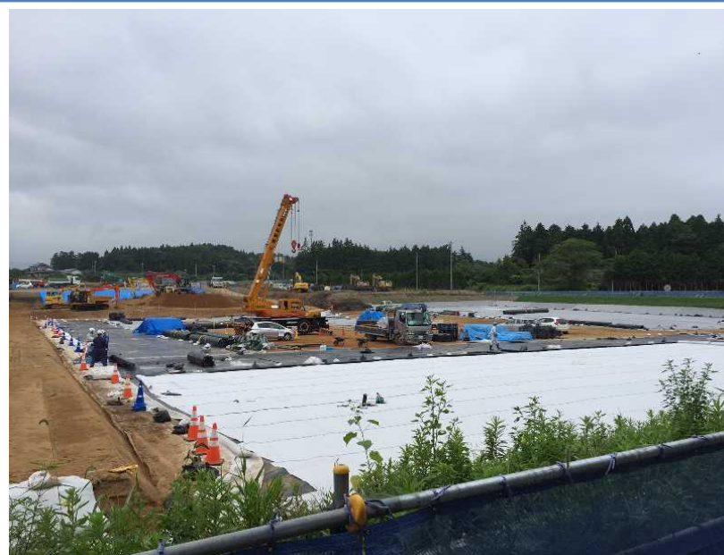
土壌貯蔵施設の建設状況（大熊工区）
