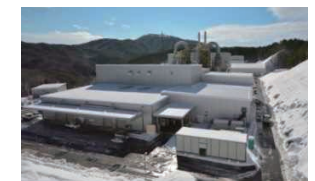
飯館村麻平地区 仮設焼却施設
