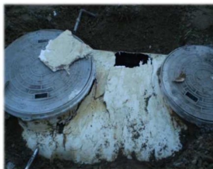
破損事例1：上部破損
