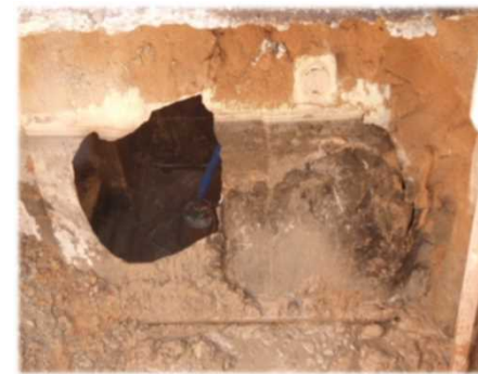
破損事例2：側部破損
