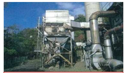
長期間稼働しているごみ焼却施設
