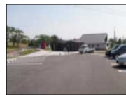
園地等の再整備と合わせた廃屋撤去
