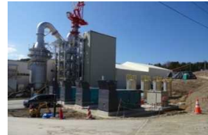
葛尾村の仮設焼却施設 (平成27年4月)
