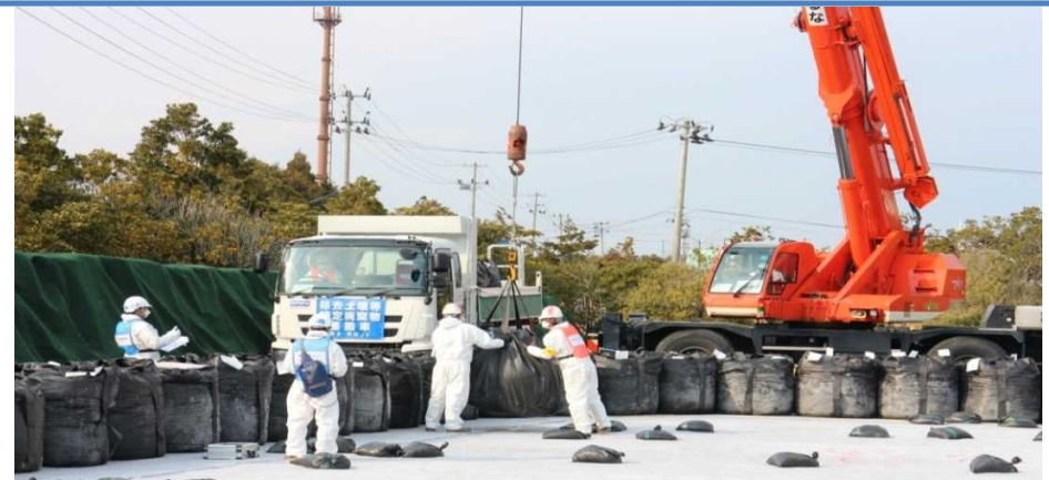
保管場への搬入・定置作業
