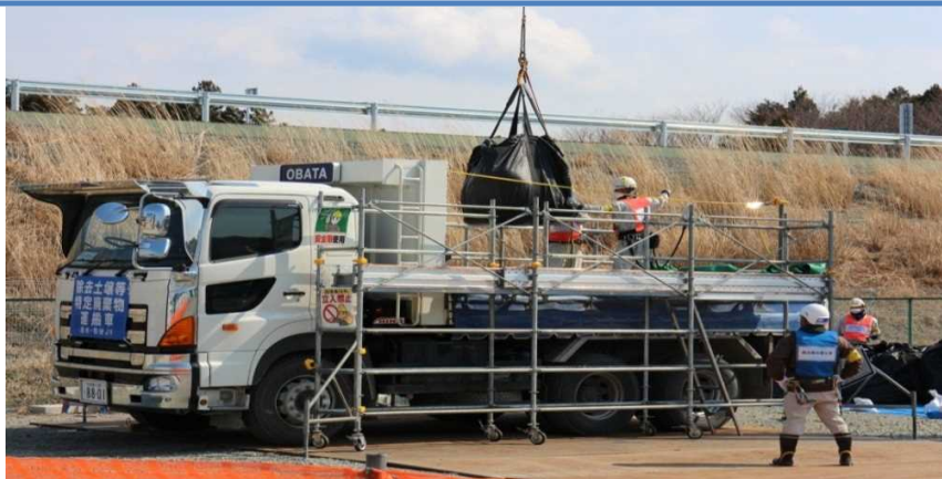
仮置場からの搬出作業
