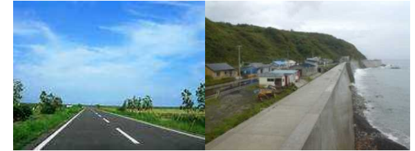
再生利用の例 (左：道路の路盤材、右：防潮堤の芯部)
