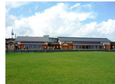
公園編入地域(青森県)の 集団施設地区整備 (種差海岸 インフォメーションセンター)
