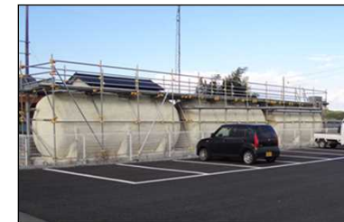
【応急仮設住宅に設置された浄化槽】
