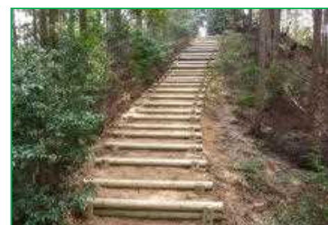
【東海自然歩道】登山道整備
