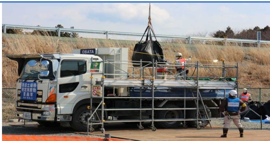
仮置場からの搬出作業
