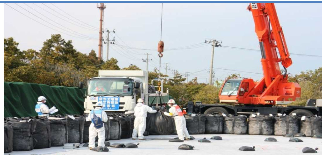
保管場への搬入・定置作業
