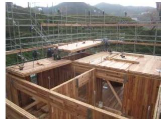
CLTを用いた施工例
