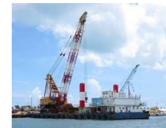
施工クレーン台船
