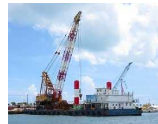
施工クレーン台船
