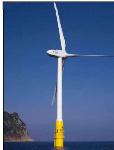
国内初2MW浮体式洋上風力発電機
