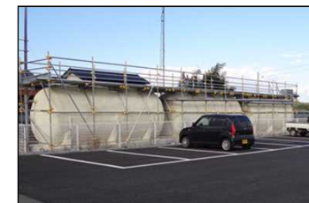
【応急仮設住宅に設置された浄化槽】
