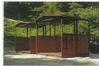
減容化のための仮設施設
