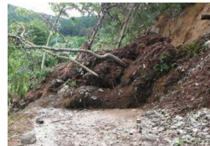
(被災例) 除染工事の進入路における土砂崩れ
