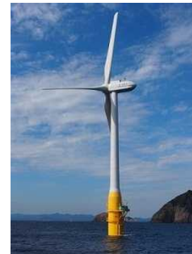
商用スケール実証機 [H25年10月に運転開始]
