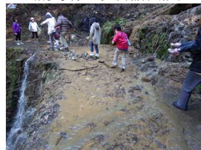
(利用が多い荒廃歩道の再整備)
