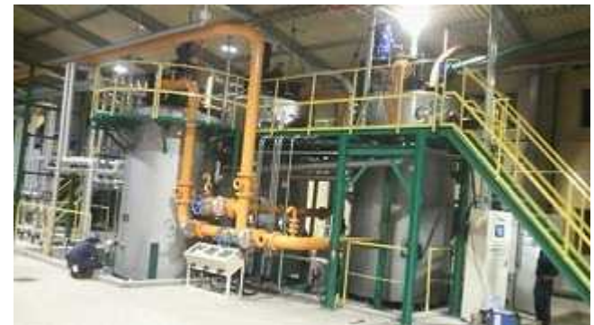
廃棄物等燃料製造装置
