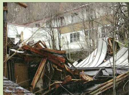
国有地内の廃屋
