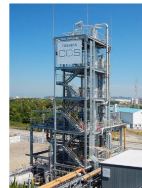
CCSパイロットプラント
