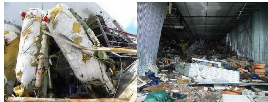
宮城県内食品工場冷凍機
