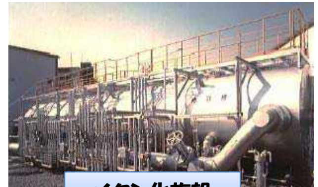
メタン化施設
