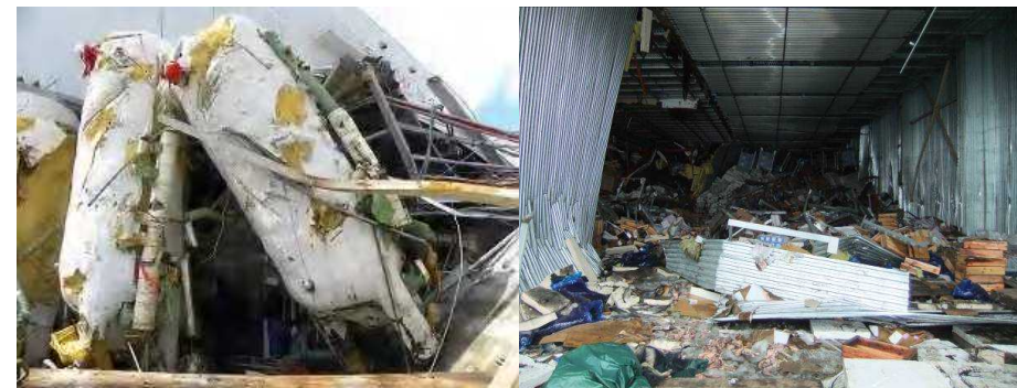
宮城県内食品工場冷凍機
