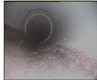
既存の埋設された配管は、実験廃水の漏洩を発見することが困難
