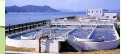
高度処理型オキシデーションディッチ方式
