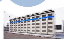
大容量蓄電池
