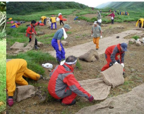
むしろ設置による植生復元作業 <造園施工管理士等>
