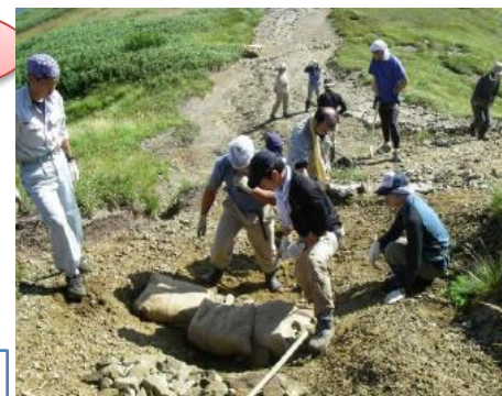
荒れた登山道が拡幅するのを防ぐ。(簡易な施設の補修、維持管理) <近自然工法等土木技術者>
