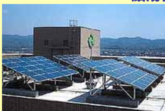
太陽光パネル
