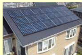
太陽光パネル
