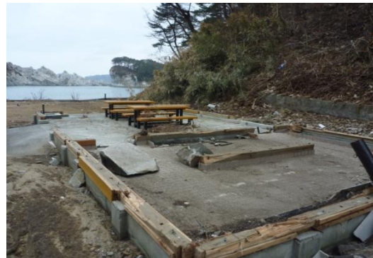
施設被害(トイレ、休憩所跡地)
